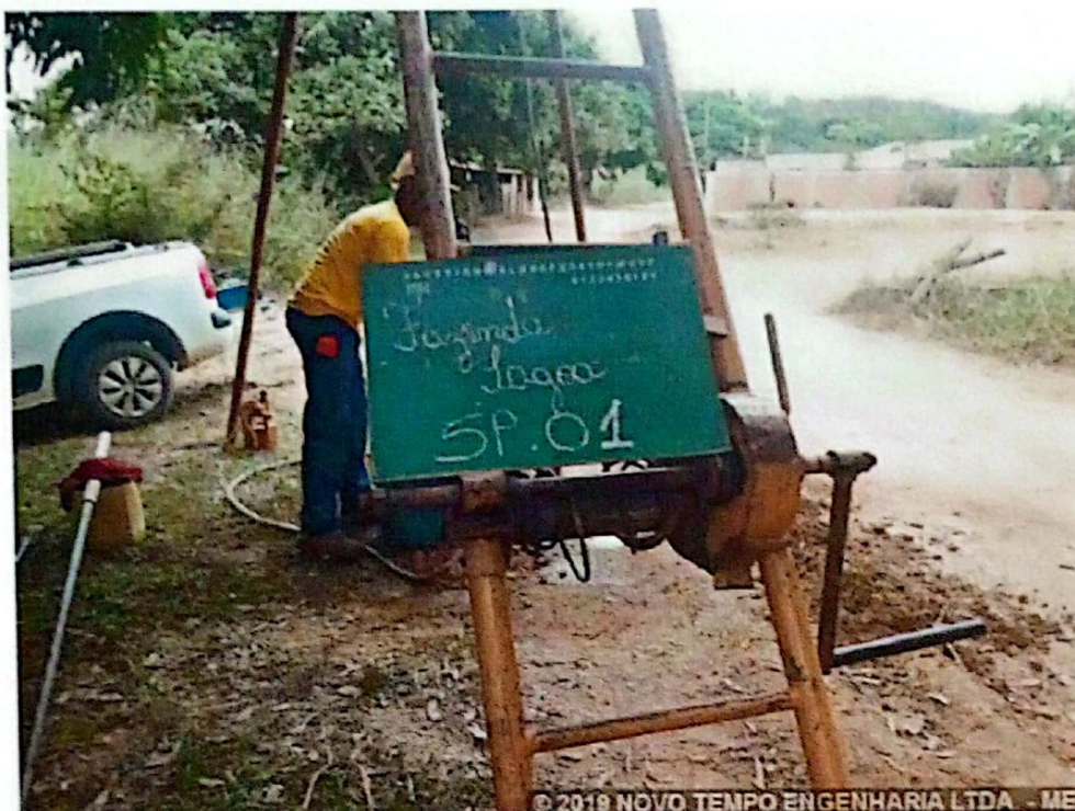
EXECUÇÃO SONDAGEM A PERCUSSÃO SP 01 – FAZENDA LAGOA/MG
