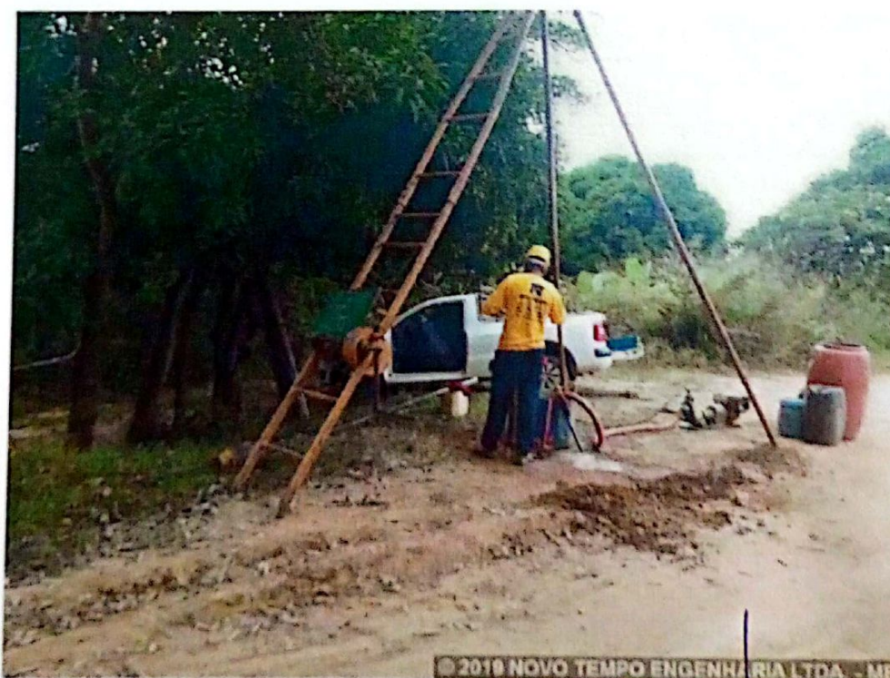
EXECUÇÃO SONDAGEM A PERCUSSÃO SP 01 – FAZENDA LAGOA/MG
