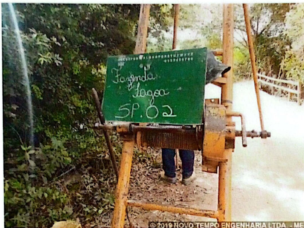
EXECUÇÃO SONDAGEM A PERCUSSÃO SP 02 – FAZENDA LAGOA/MG
